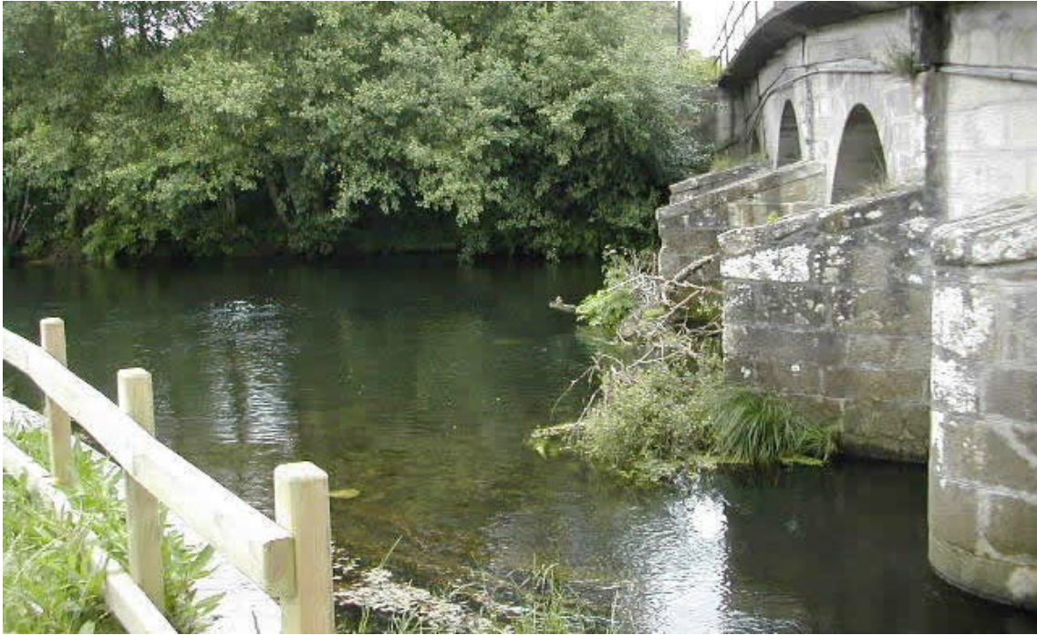
Ponte do río do Porto en Calo.
